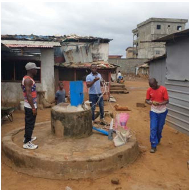
Onderhoud en reparatie waterput en touwpomp in Monrovia
