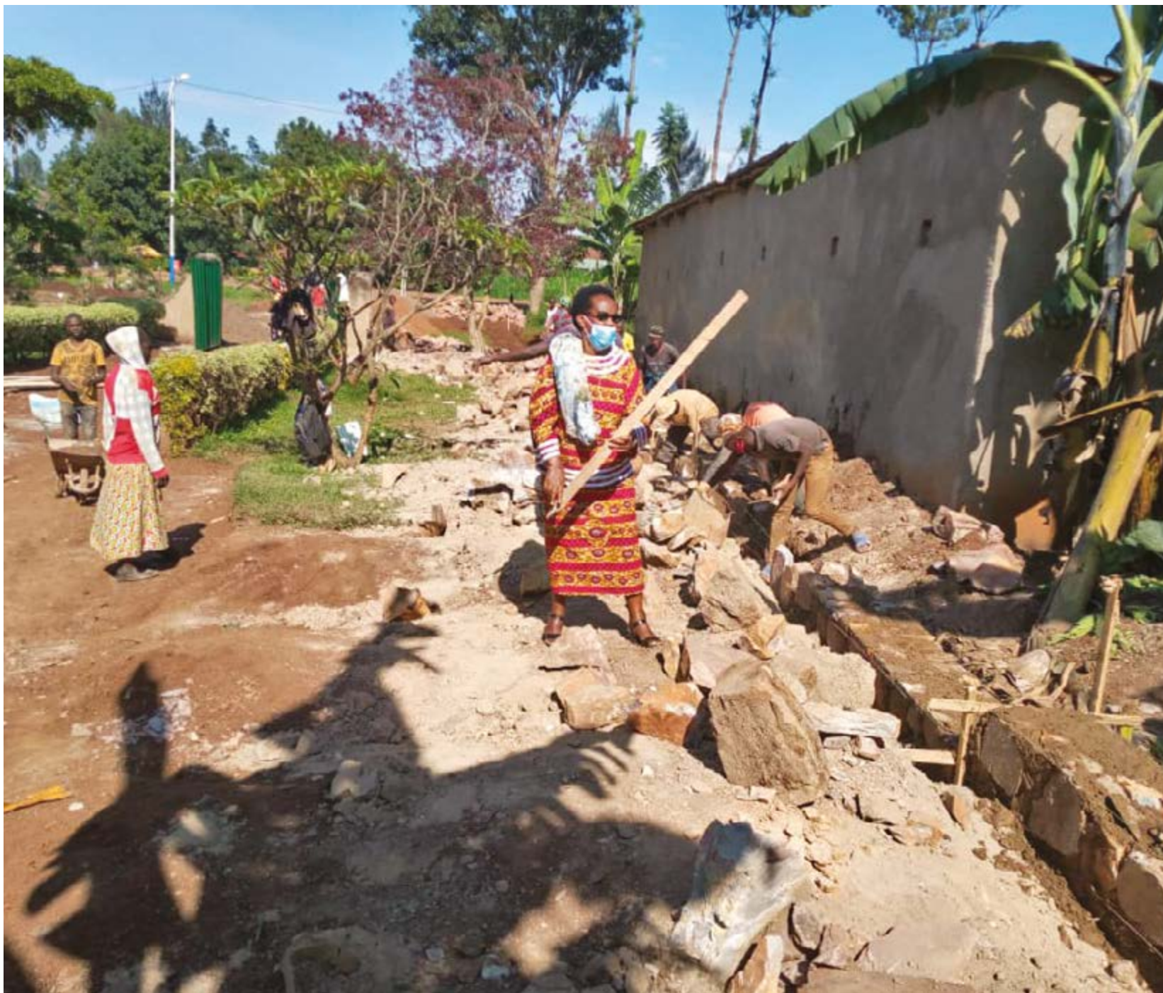
Rose bouwt mee aan de omheining van het complex in Kayonza
