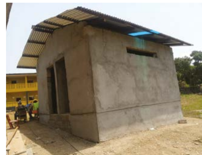
Bouw extra toiletgebouw
