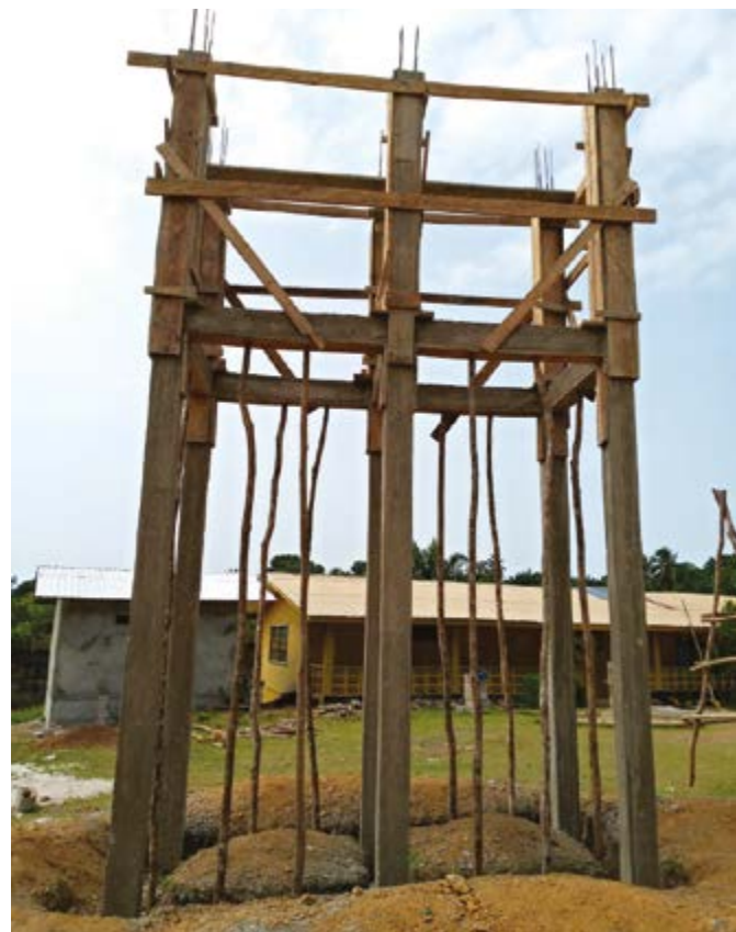
Bouw watertoren voor de school
