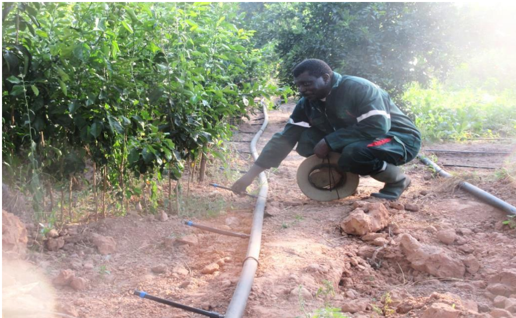
Aan de pijpjes die van de hoofdwaterleidingbuis afkomen worden de druppelslangen bevestigd.
