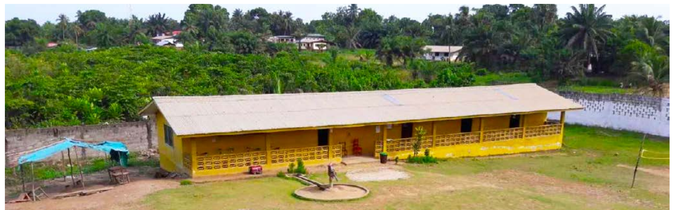
Lerarengedebouw met waterpomp
