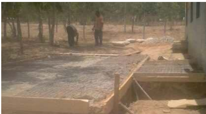
Fundering nieuwe toiletten
