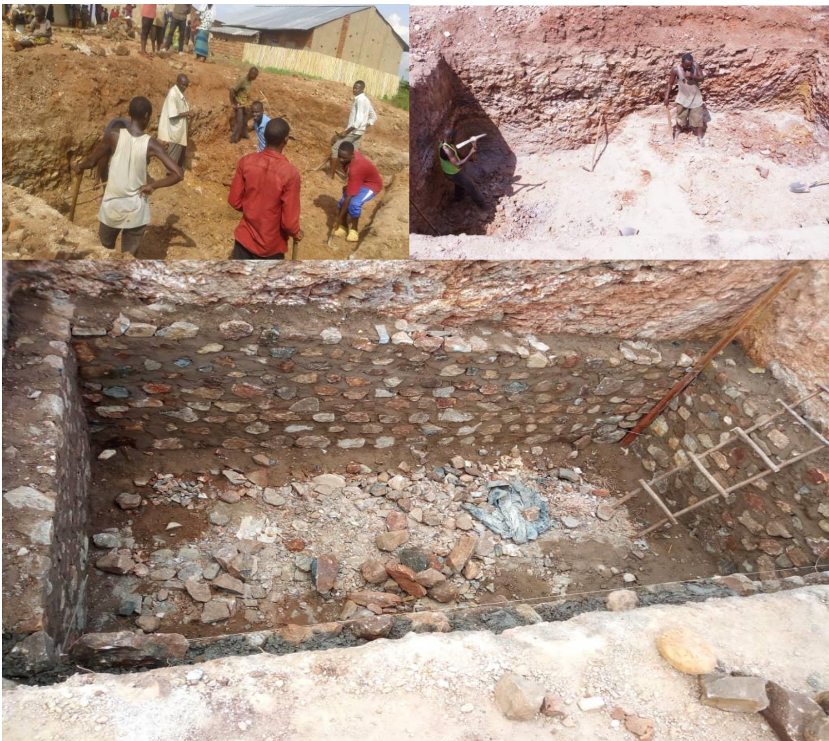
Fig.3 Bouw van rioleringssysteem
