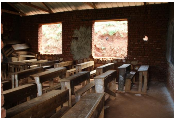
Fig.7 Overzicht klaslokaal voor renovatie
