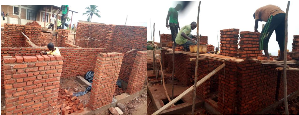
Fig.4 Bouw van sanitaire blok
