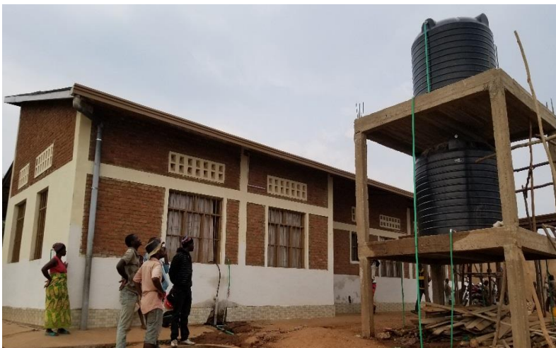
Fig.1 Installatie van watertanks
